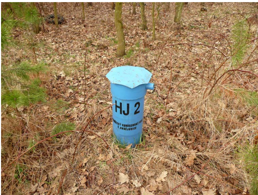
Foto 3: Objekt HJ2 (průzkumný vrt) zmapovaný v rámci pasportizace vodních zdrojů. Průzkumný vrt se nachází v místech vjezdového portálu Hosínského tunelu. Účel vrtu se nepodařilo zjistit, pravděpodobně se jedná o monitorovací vrt. Situace vrtu - příloha 2.
